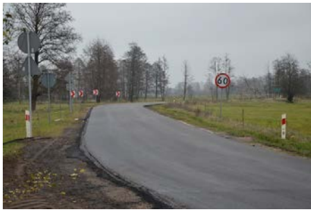
Odcinek drogi gminnej relacja Treblinka – Grądy
